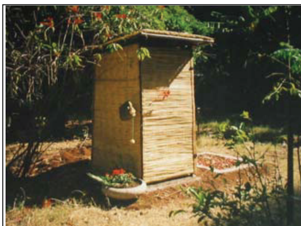
Construction légère à déplacer d'un puits à l'autre
