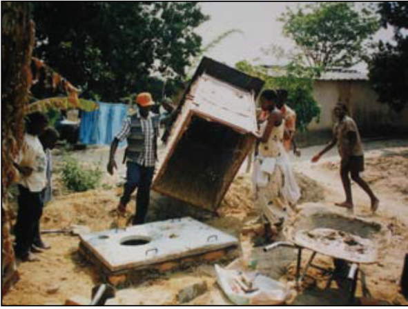
Déplacement de la cabine sur la deuxième fosse
