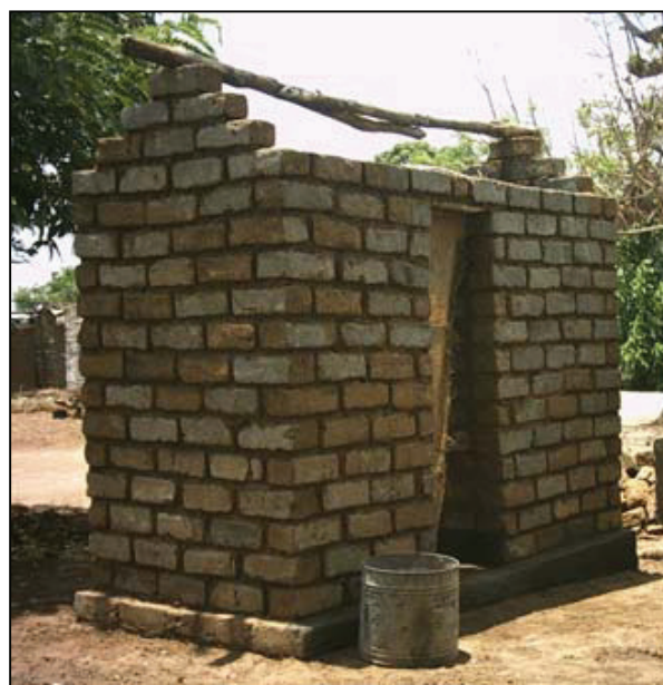
Construction lourde sur 2 puits utilisés en alternance
